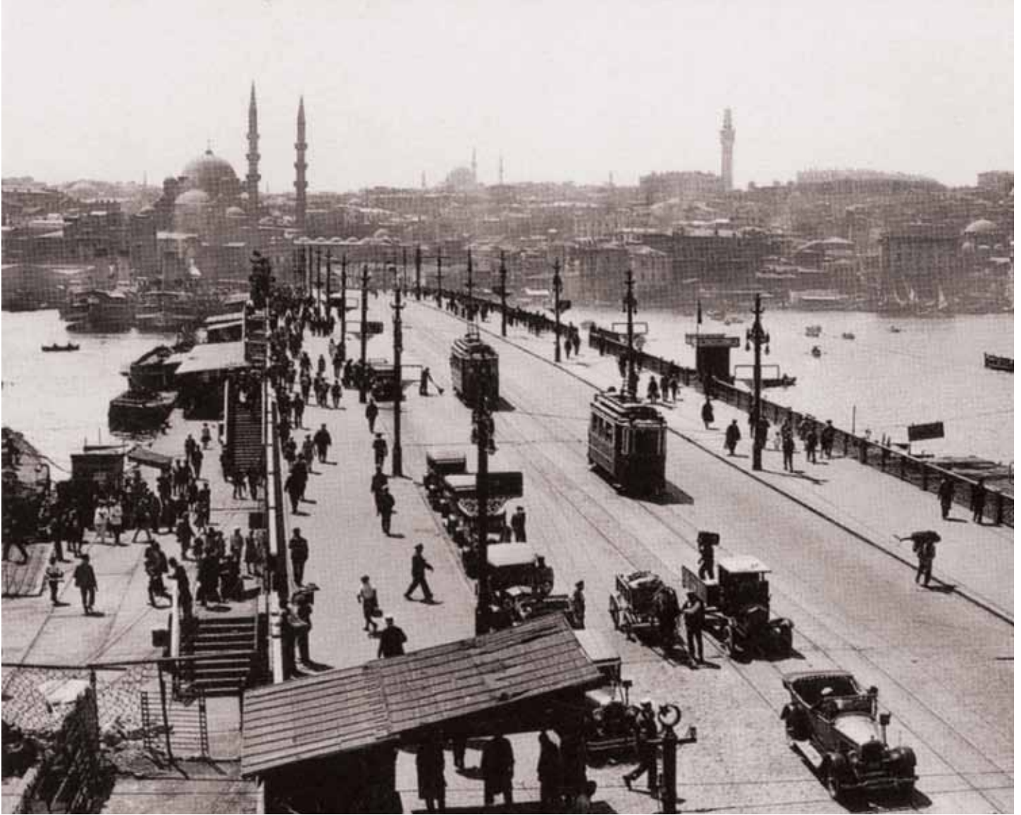
Galata Köprüsü 1935 / Galata Bridge 1935
